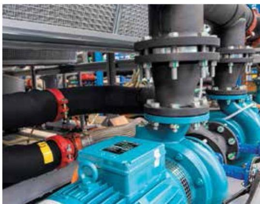
Выбор оптимального решения для насосов, несомненно, является наиболее сложной задачей для проектировщика. Чиллеры Uniflair имеют собственный насосный агрегат, который может приводиться инвертором.
